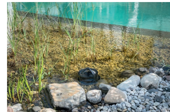
Die gemauerte Einstiegstreppe wurde mit einer Antirutschfolie ausgekleidet (Bild oben). Den Oberflächenskimmer platzierte der Naturpoolbauer in eine der Flachwasserzonen (Bild unten).
