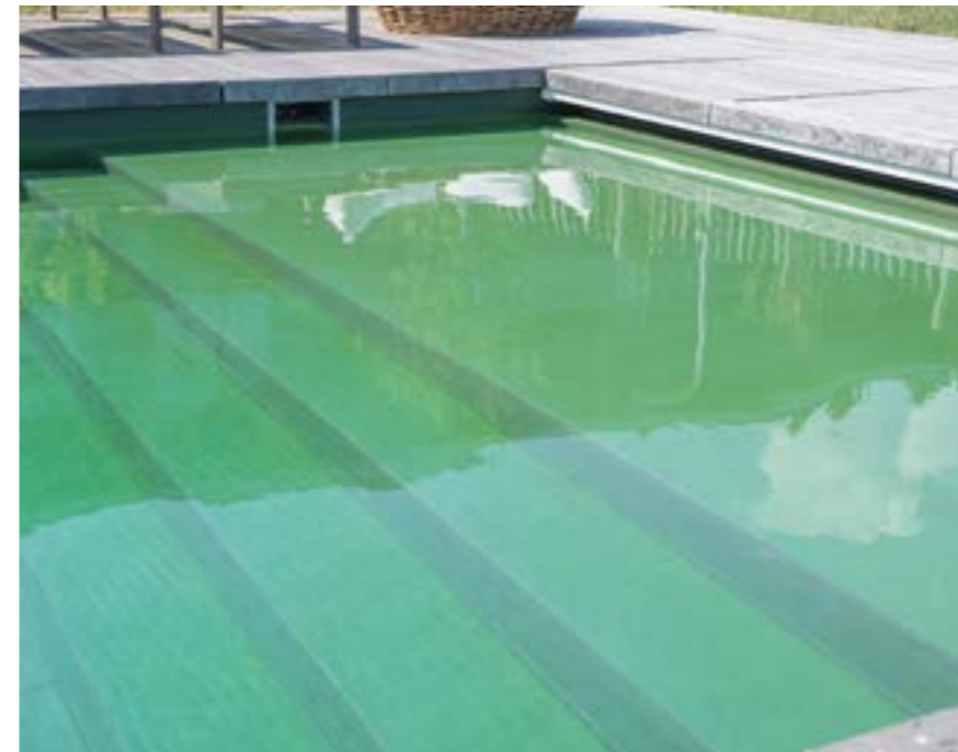
Eine breite Treppe und der Flachwasserbereich laden Groß und Klein ein, den Naturpool nicht nur fürs Schwimmen, sondern auch fürs Relaxen zu nutzen. Am Beckenrand: einer von vier Skimmern und der Schlitz, aus dem der Unterflurrollladen austritt.
