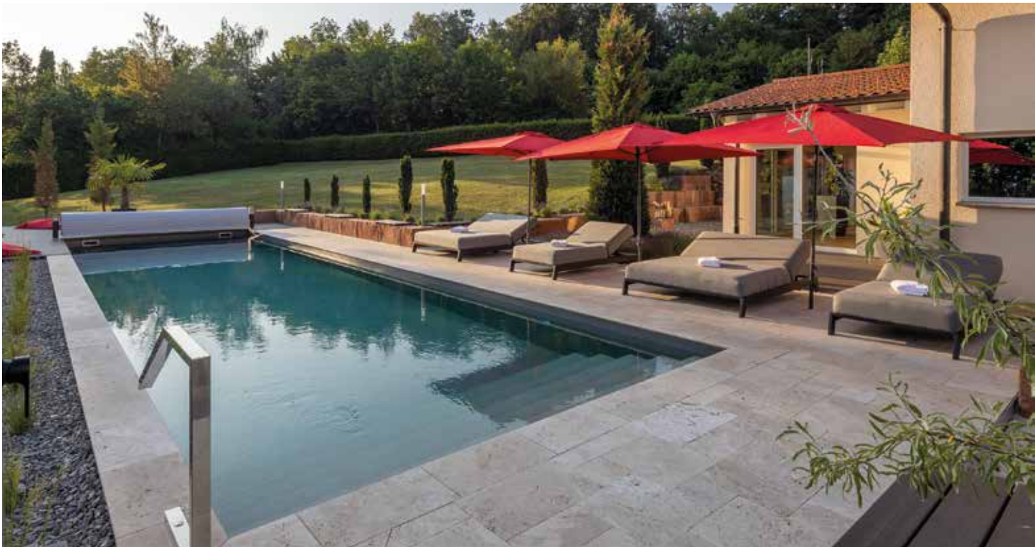
Die breite, fünfstufige Treppe bietet einen angenehmen Einstieg ins extralange Becken. Bodenbelag: Travertin.
